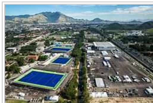
La konstrukto di ludeyi en Deodoro.
